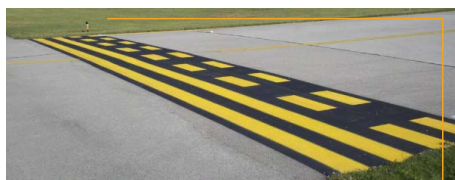
HOLDING POSITION: POSIZIONE DI ATTESA INGRESSO PISTA
